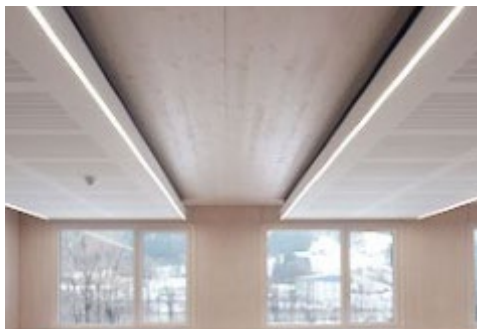
Die Akustikdecke bricht den Schall und verringert die Nachhallzeit.
