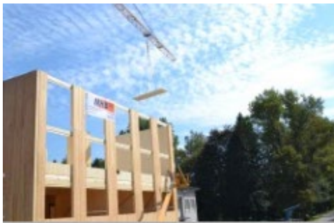
Der Holzbau von Binderholz wurde in nur zwölf Arbeitstagen errichtet.
