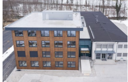
Das Heiz- und Kühlsystem von Variotherm sorgt für ein gesundes und ruhiges Raumklima.
